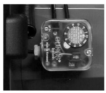
Реле контроля давления воздуха работает как дифференциальное реле давления и служит для контроля давления у горелок с наддувом. На заводе реле контроля давления воздуха предварительно установлено на 8 мбар.
