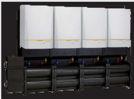
Котлы MCA в каскаде
